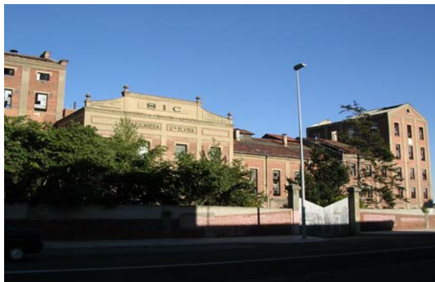
Figura 1. Azucarera “Santa Elvira” (León). Fachada principal.
