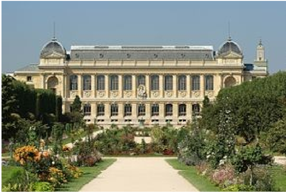
Figura 2. Vista parcial del Jardin des Plantes en la actualidad. Al fondo la Galerie de l'Evolution, uno de los edificios del Muséum, y un poco por delante la estatua de Buffon, sentado mirando a la Galería (ver la otra ilustración).
